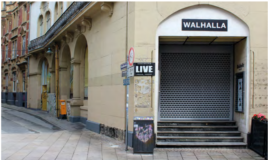
Das einstige Varieté-Theater Walhalla in bester Wiesbadener Innenstadtlage bröckelt seit Langem ungenutzt vor sich hin.
