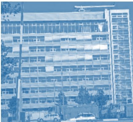
Baupfusch beim Abfallwirtschaftsbetrieb. Trotzdem haftet der Steuerzahler.
