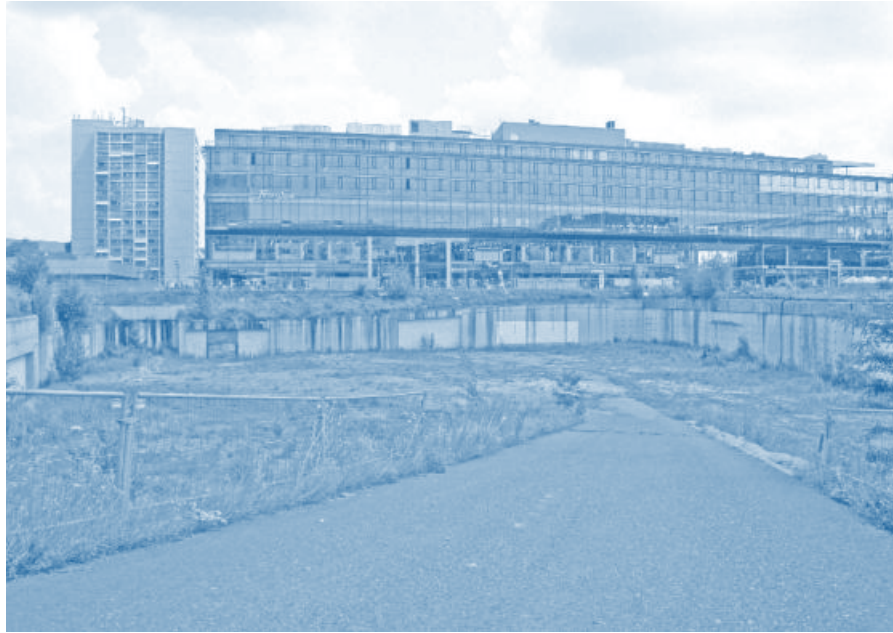
Ewige Baustelle - das „Wiener Loch“ in der Landeshauptstadt Dresden.
