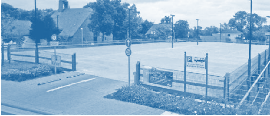
Klassische Fehlinvestition. Das verwaiste Parkdeck in Seligenstadt.
