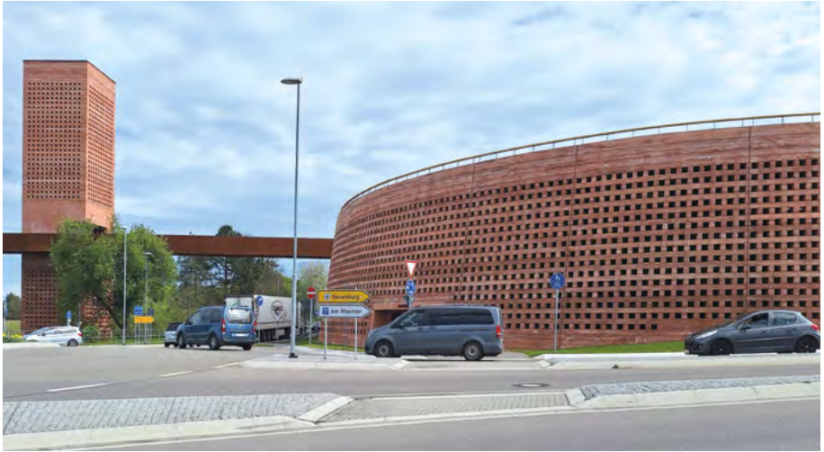
Dieses Parkhaus in Neuenburg steht oft nahezu leer.
