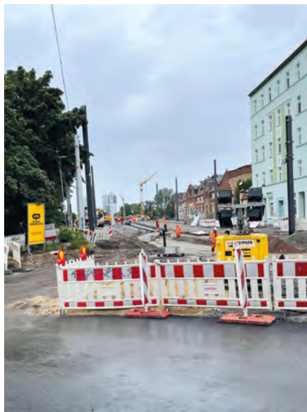
Blick auf die Baustelle Mansfelder Straße / Ersatzneubau Elisabethbrücke.
