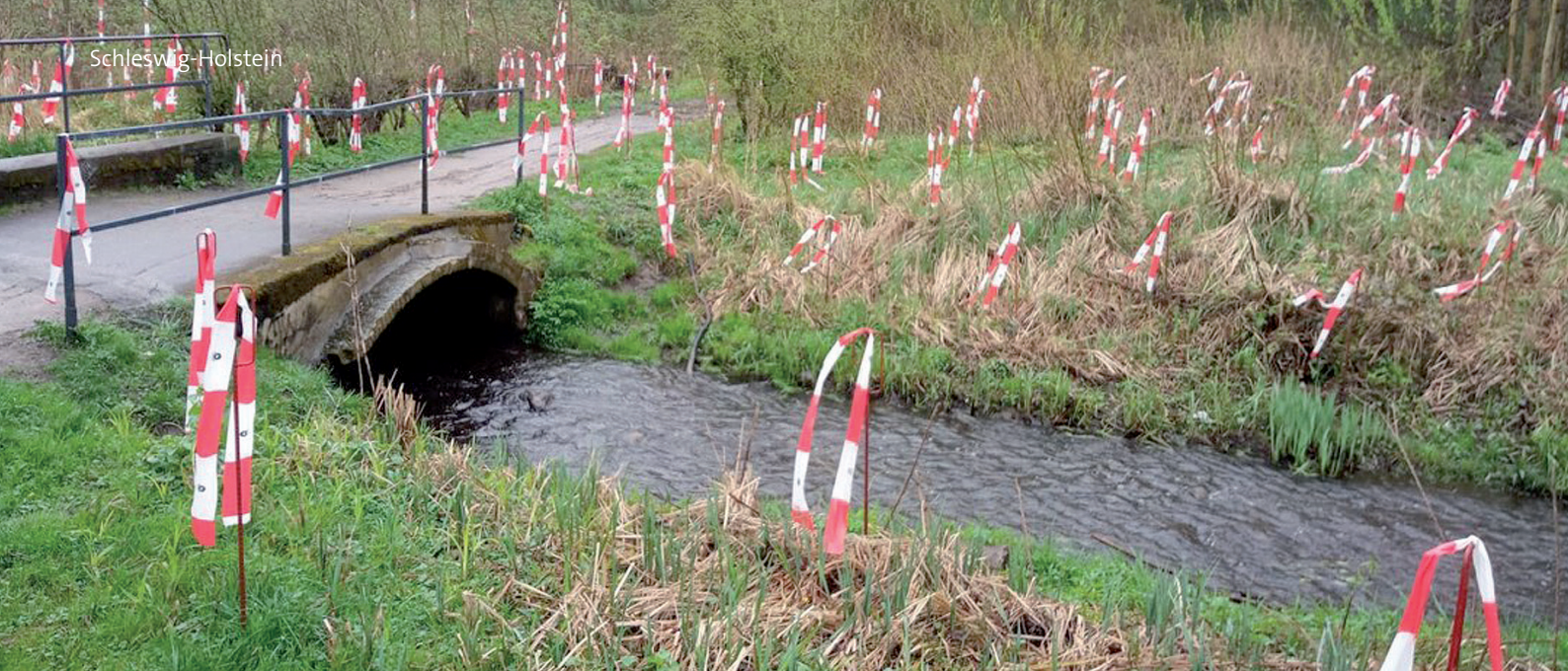
Bevor die alte Brücke über den Mühlenbach abgerissen werden konnte, musste verhindert werden, dass Vögel im Baufeld nisten. Die Vergrämnungsmaßnahmen mit Flatterbandstreifen sind in den 350.000 Euro Baukosten enthalten.
