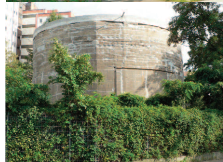
Der Schwerbelastungskörper in Schöneberg. Fast eine Million Euro haben die Beton-sanierung und der neue Aus-sichtsturm gekostet.
