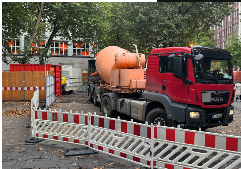
Mehrere Tage rollten Lastwagen an, um die unterirdische Toilettenanlage zu verfüllen.
